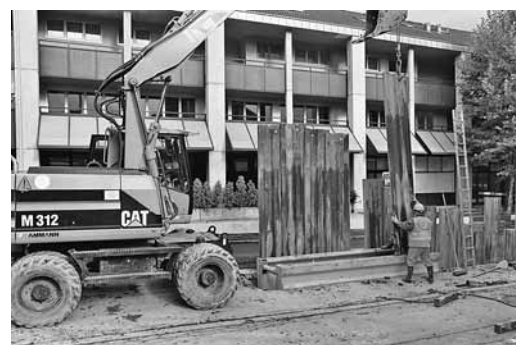
Figura 8: montaggio delle puntellature in condizioni di sicurezza.
