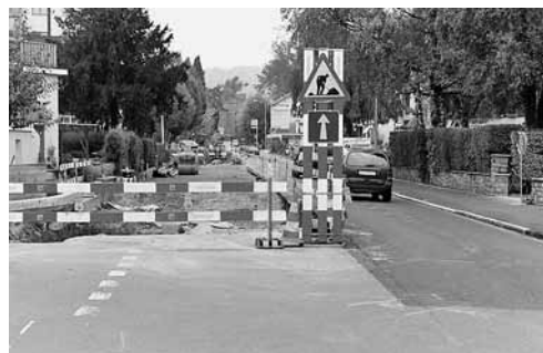
Figura 2: cantiere segnalato correttamente.
