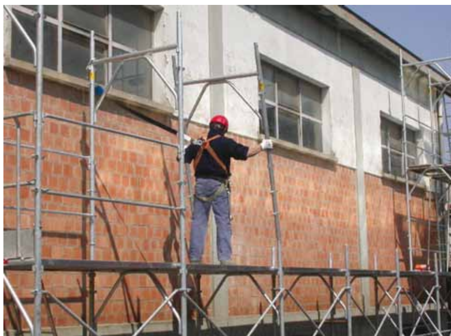
Foto 4. Montaggio ponteggio a telai con utilizzo DPI arresto Caduta.
