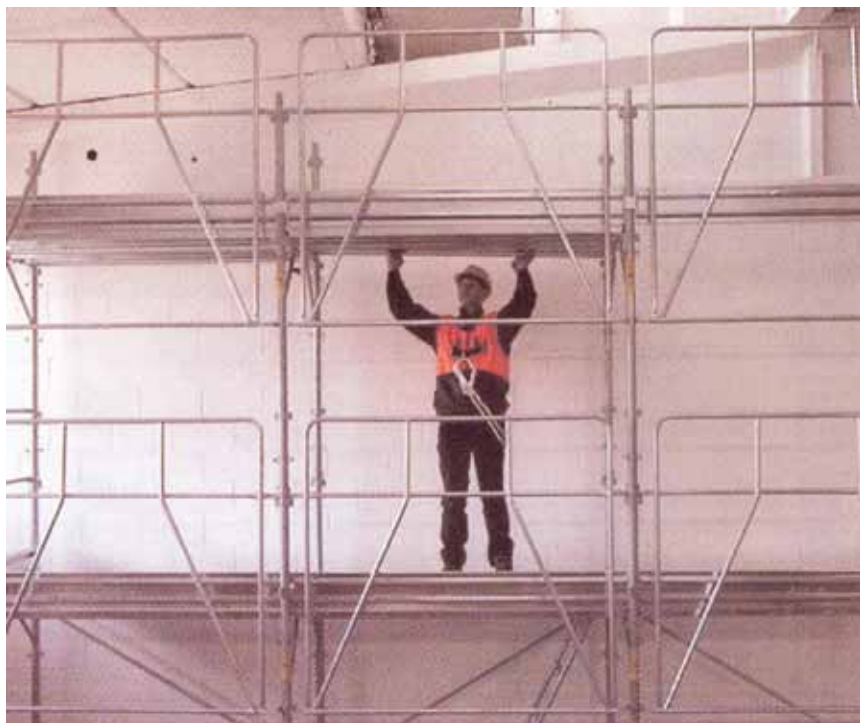
Foto 1. Montaggio del ponteggio ad H in sicurezza con parapetto definitivo dal di sotto.
