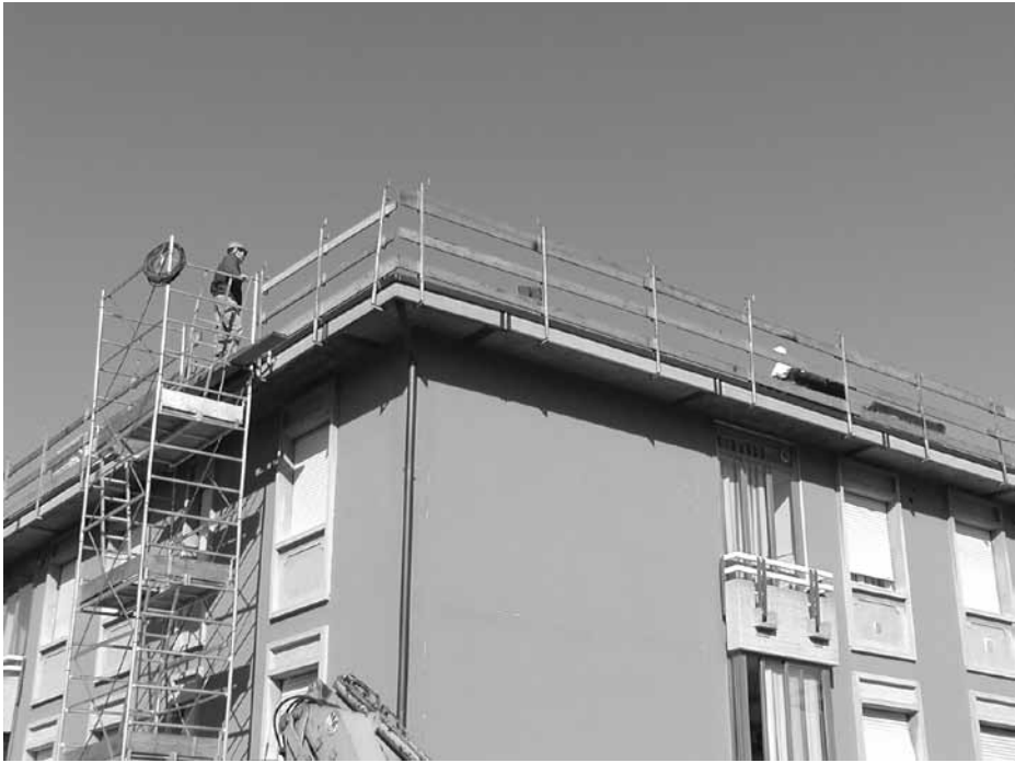
Sistemi provvisori di protezione bordi tetti
