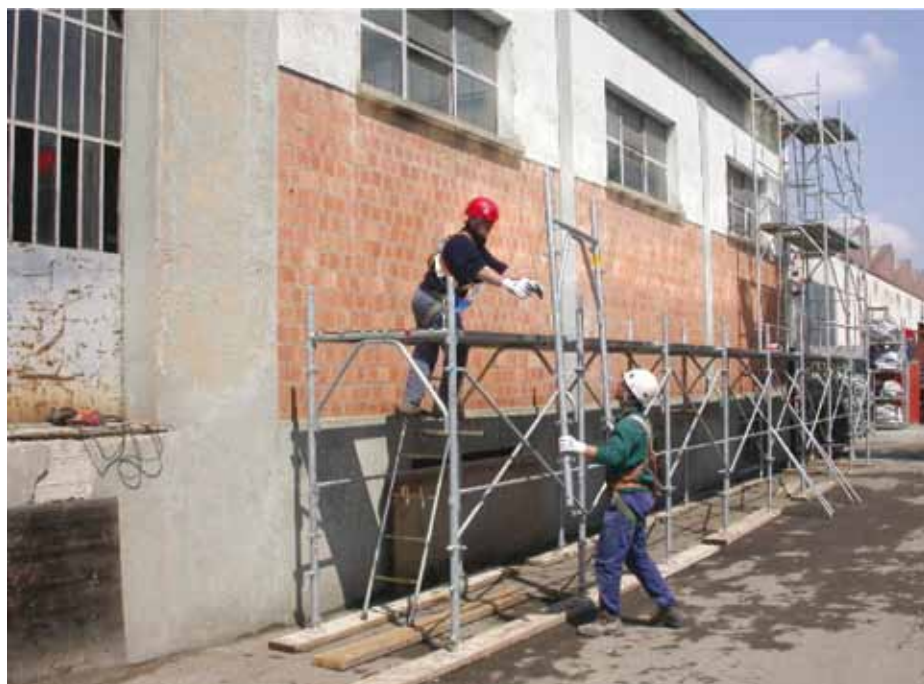
Foto 3. Montaggio ponteggio a telai con metodo di punta.
